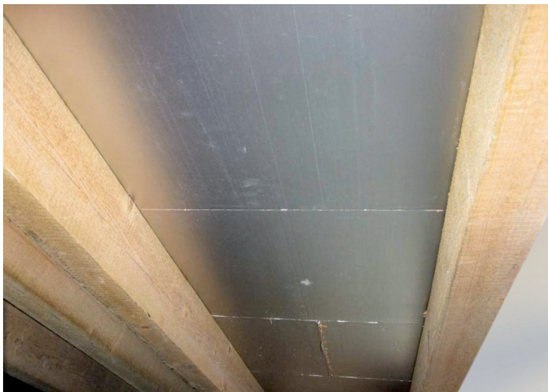
Foto 1: Interior de una cubierta a dos aguas con las vigas del techo y la capa de aislamiento.
