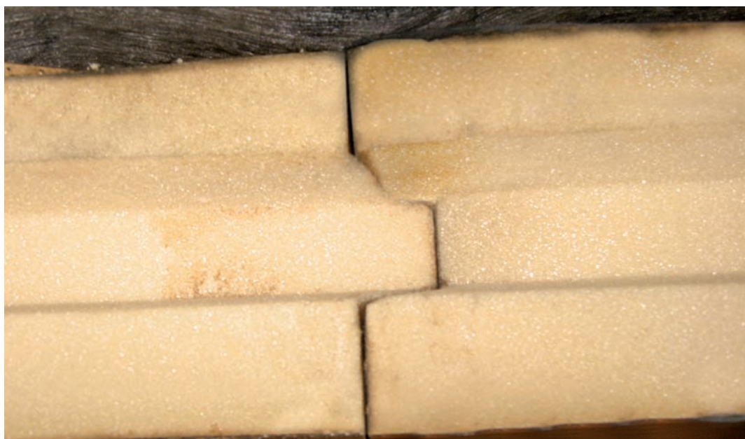
Foto 3: Paneles aislantes instalados ajustados entre sí.
